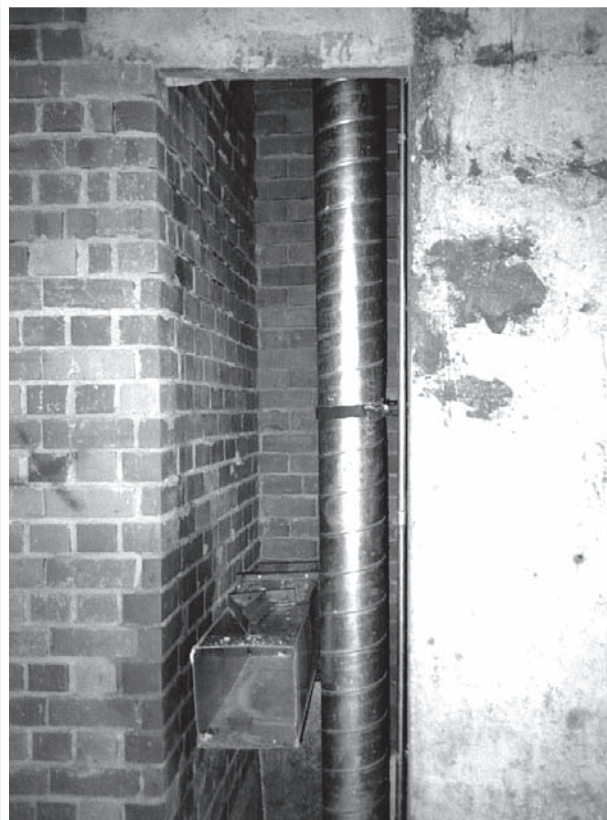
ภาพที่ 14 : ภาพแสดงการติดตั้ง ระบบฉนวนสำเร็จรูปที่ท่อ Risers
