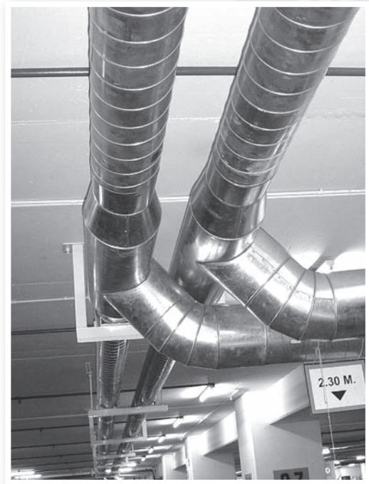
ภาพที่ 13 : ภาพแสดงการติดตั้ง ระบบฉนวนสำเร็จรูปที่ท่อ Main
