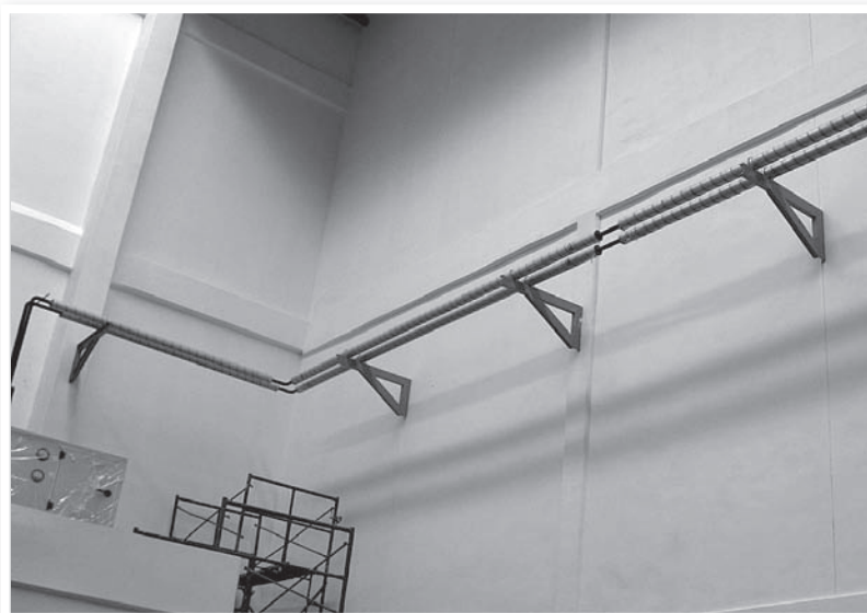
ภาพที่ 15 : ภาพแสดงการติดตั้งท่อหุ้มฉนวนที่สามารถทำได้รวดเร็ว โดยเฉพาะในช่วงท่อตรงในระยะยาวๆ
