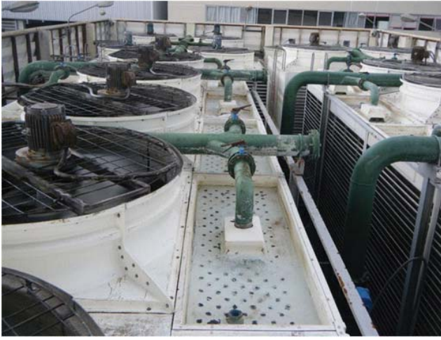
รูปที่ 9 ถาดน้ำด้านบนหอผึ่งเย็นหลังจากปรับปรุงปริมาณโอโซนให้เป็นไปตามข้อกำหนด
