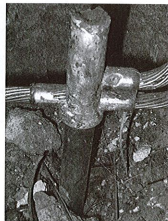
รูป แสดงตัวอย่างการเชื่อมสายต่อหลักดินกับแท่งหลักดินที่ถูกวิธี (ตามวิธีที่ 2)
